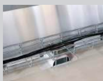
Alternativa n. 2: La canalina portacavi viene fissata sui supporti dei profili sulla parte posteriore dei triangoli
