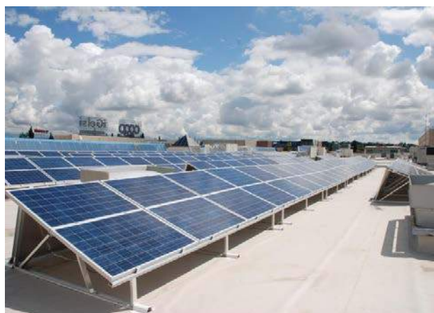
Sistema MCG 3.0 "posa inclinata 20 gradi"
