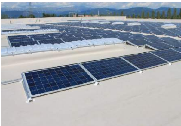
Sistema MCG 3.1L "posa inclinata 12 gradi" per zone a basso carico di vento
